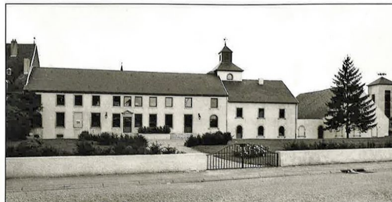
Vue arrière de la mairie
