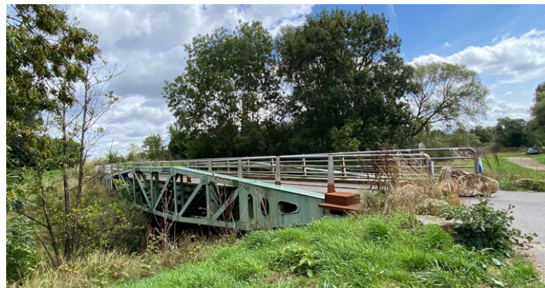
La passerelle « baleine » encore visible
